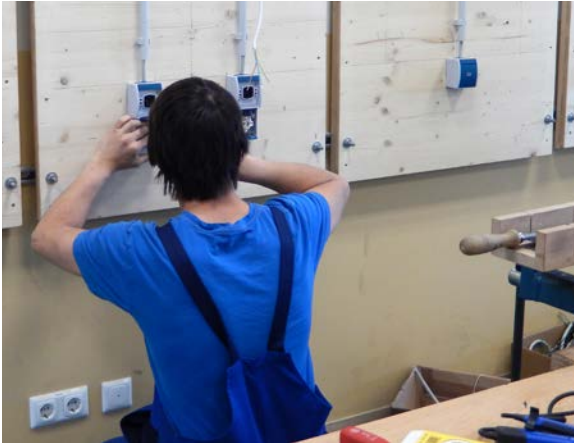
Foto: HBS Elektrobau GmbH
